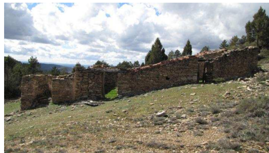
Fachada principal situada al este.
