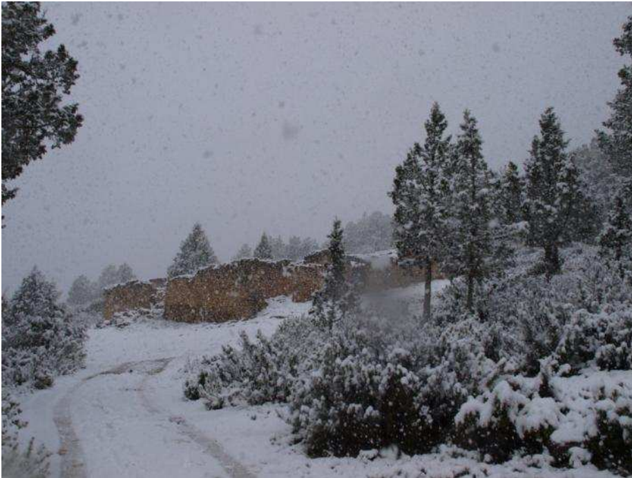
Hospital de Sangre de los Corrales de los Garcías, El Collado (Alpuente, Valencia).
